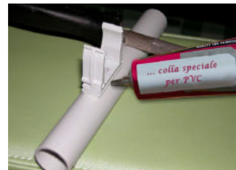
Fig. 4 - ...e con la colla per PVC si uniscono le due parti.
